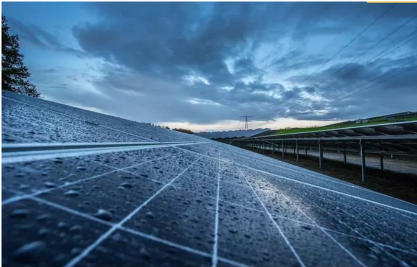
▲ Rondom de buurtschap Nettelhorst zijn al zonneparken aangelegd. © Arjan Gotink
